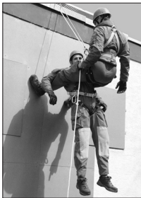
Voorbeeld: Evacuatie met Milan afdaalapparaat.
